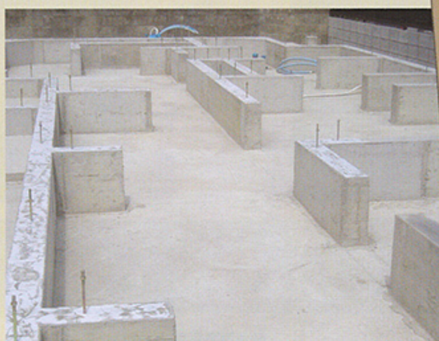
ベタ基礎(仕様)の完成
