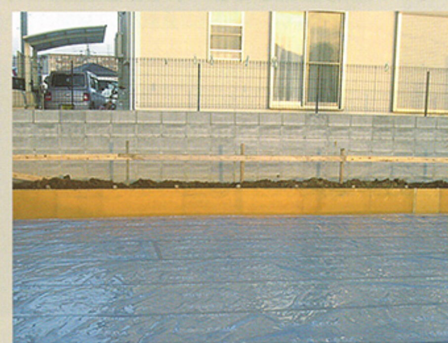
ターメッシュEMシート敷設完成
